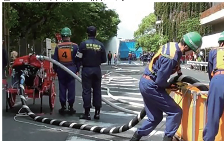
ポンプ(写真左)は水槽(右)から給水し、中央 ずっと奥で放水している
