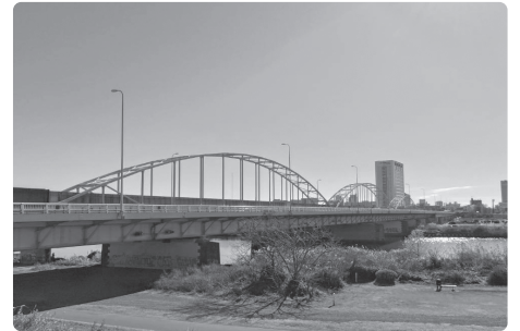
多摩川大橋 昭和24年完成
