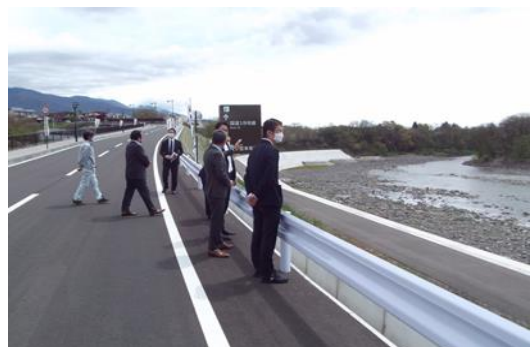
復旧した海野宿橋の視察
