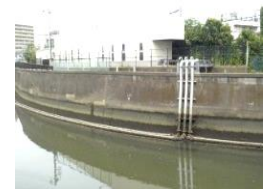
既設浄化施設(呑川)
