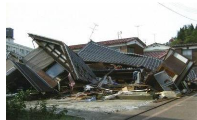
倒壊家屋の現場写真
