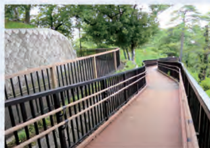
緩やかな勾配の木道のスロープ
