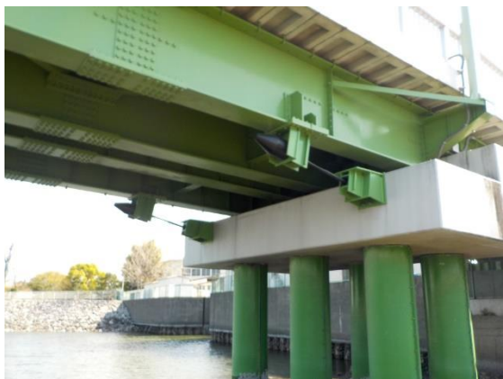
大森東避難橋 昭和47年竣工
