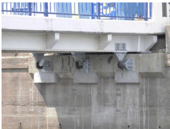
天神橋 昭和36年竣工(上部)
