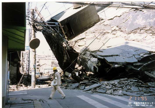
[建物倒壊による道路閉塞]
