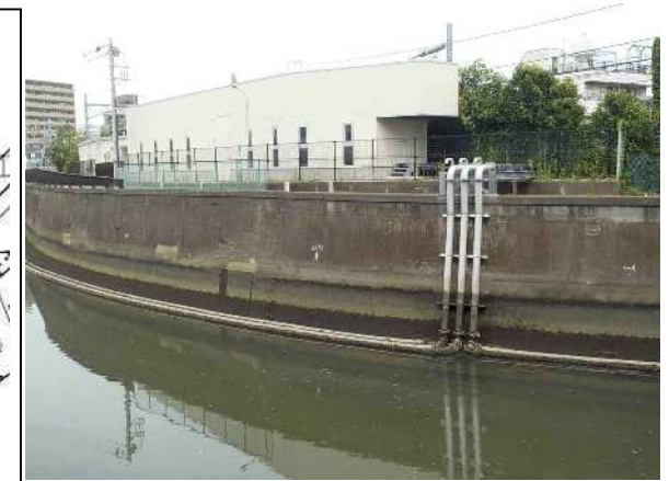
写真 2.1 高濃度酸素水浄化施設全景
