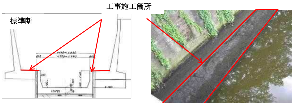
図 2.20 工事の施工箇所
