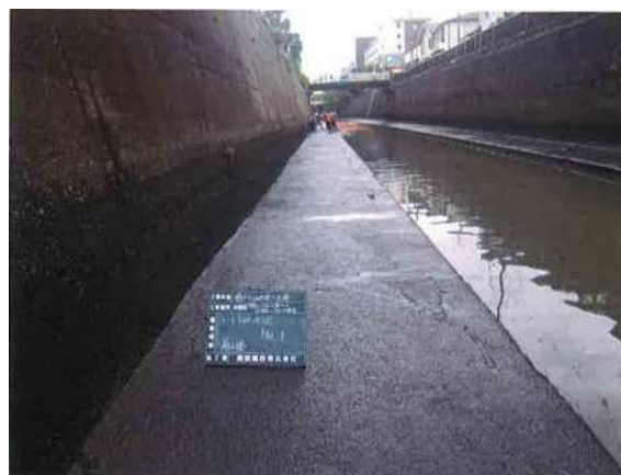
写真 2. 11 施工後写真（一本橋上流側）
