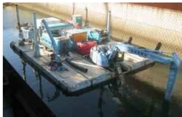
写真 2.5 高濃度式ポンプ浚渫船
