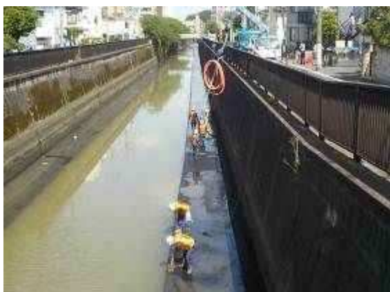
写真 2. 8 施工状況写真（遠景）
