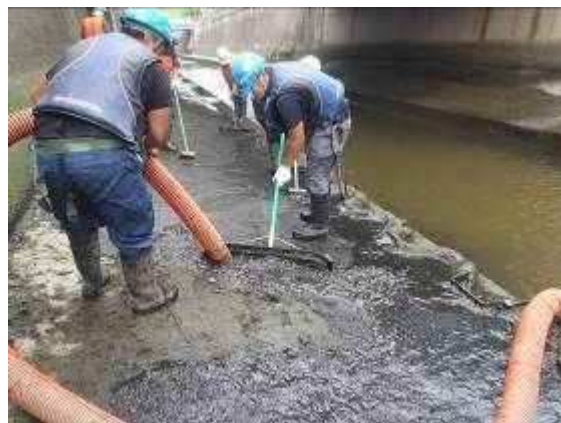
写真 2. 9 施工状況写真（近景）
