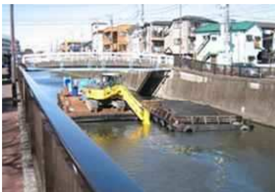
写真 2.4 バックホウによる浚渫状況
