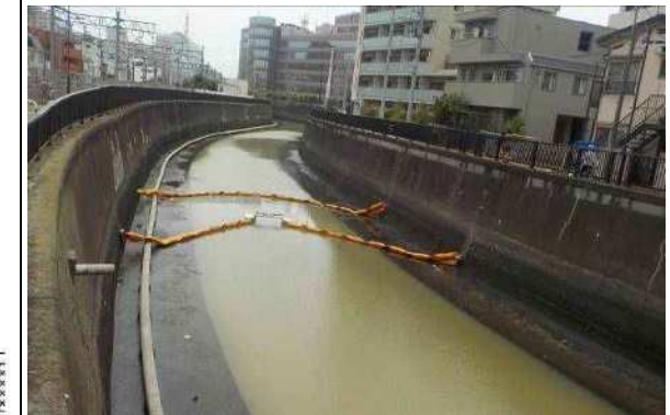
写真 2.2 放流管配管状況
