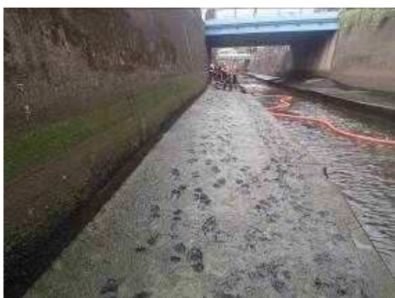
写真 2. 10 施工前写真（一本橋上流側）
