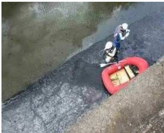
写真 2. 6 汚泥堆積状況（遠景）
