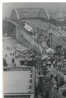
蒲田陸橋開通 (昭和37年)
