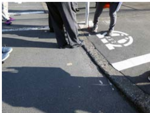
歩道と車道の境にある段差
