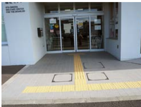
道路から建物出入口までのバリアフリー化 (志茂田福祉センター)
