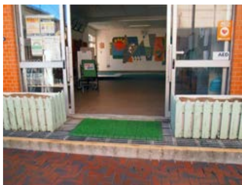
段差のある出入口
