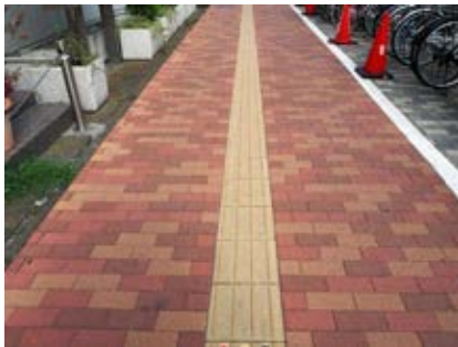
歩道部の路面の凹凸の改善 (環八通り)
