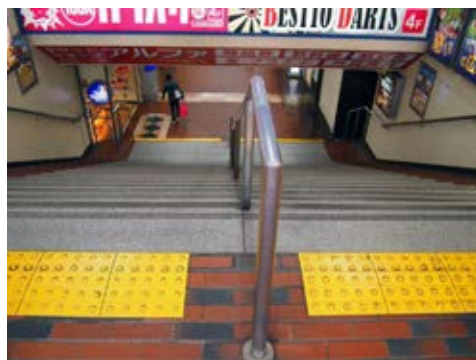
エスカレーターやスロープがない出入口
