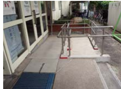
災害時に避難所となる施設のバリアフリー化（新宿小学校）
