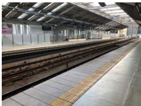
ホームドアが設置されていないプラットホーム
