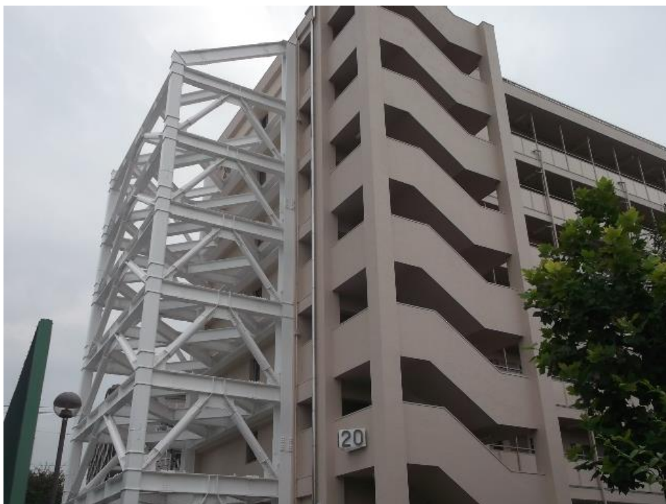
区営住宅の耐震補強工事
