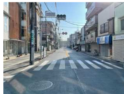
羽田バス通り（無電柱化部）
