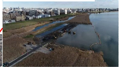
R5河道掘削(陸上): 25,000m 3 (予定)
