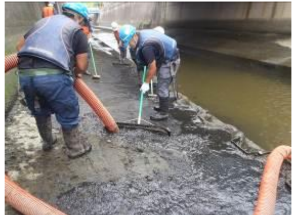
写真 2.7 施工状況写真（近景）
