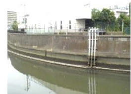
既設浄化施設(呑川)
