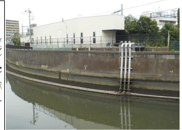
写真 2.1 高濃度酸素水浄化施設全景
