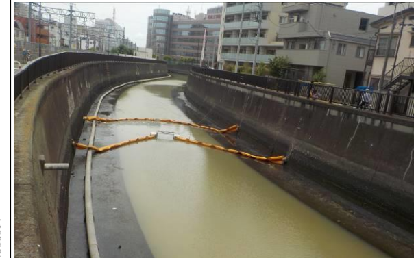
写真 2.2 放流管配管状況
