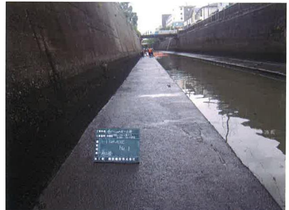
写真 2.9 施工後写真（一本橋上流側）
