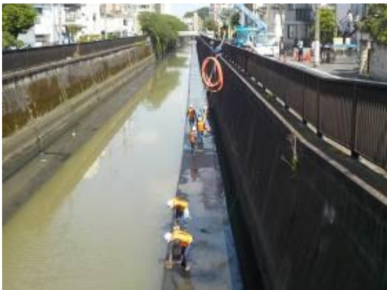
写真 2.6 施工状況写真（遠景）
