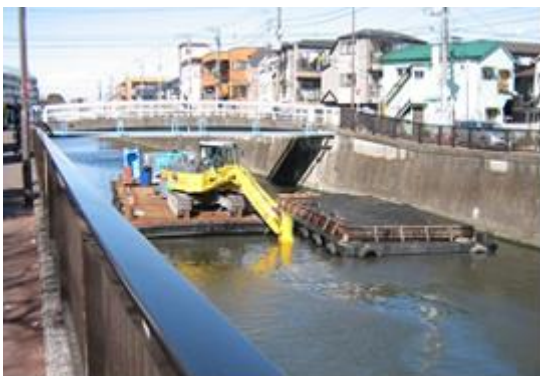
写真 2.4 バックホウによる浚渫状況
