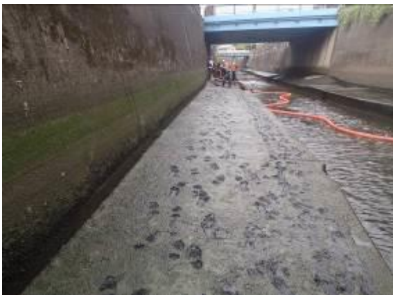
写真 2.8 施工前写真（一本橋上流側）
