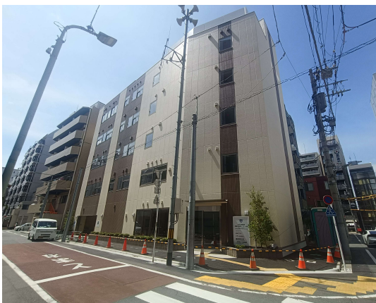
蒲田西地域力推進センター分館
