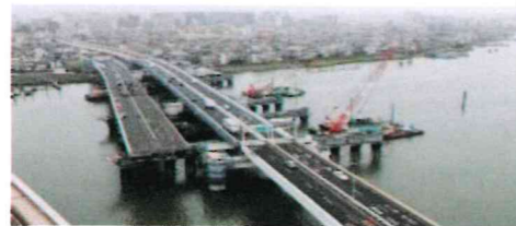
新しい橋梁を供用している様子
