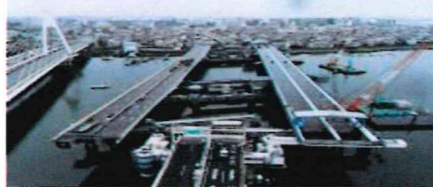
古い橋梁のスライド後の様子
