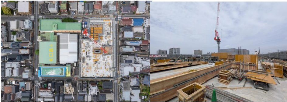
5F・R階躯体工事
