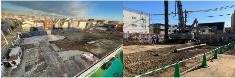
基礎解体工事
