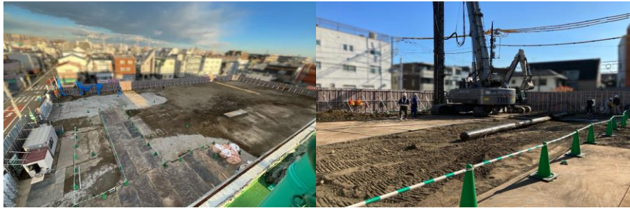
基礎解体工事
