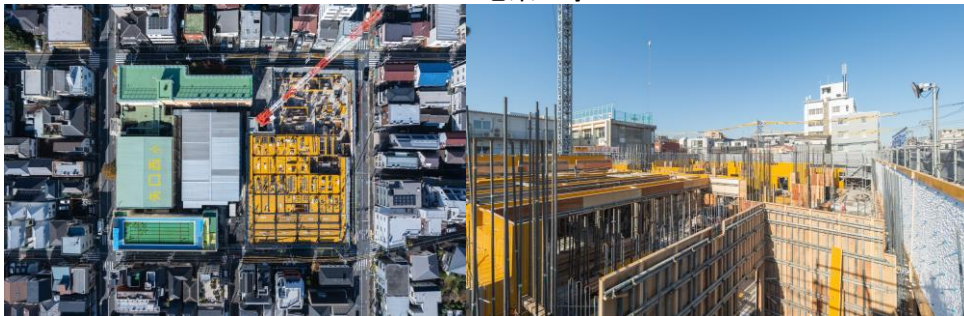
1F躯体工事
