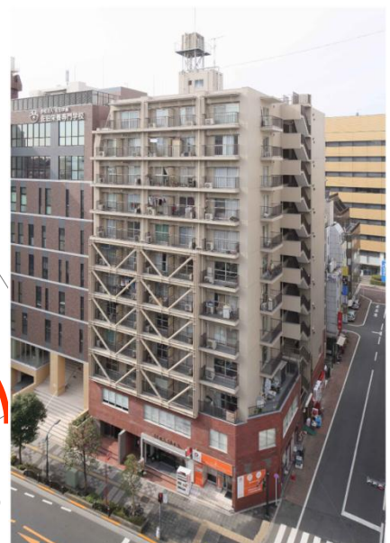
特定緊急輸送道路沿道建築物の耐震補強例
