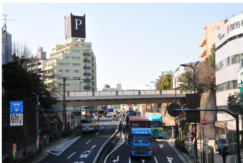
耐震補強を施した新馬込橋
