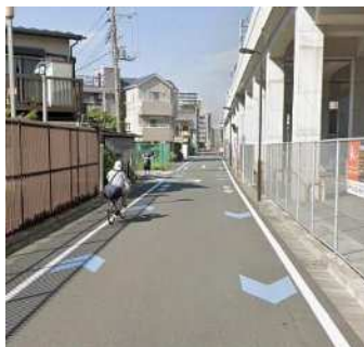
■矢羽根型路面表示による区道整備
