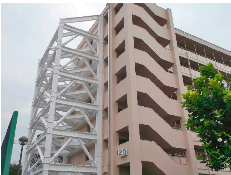
区営住宅の耐震補強工事
