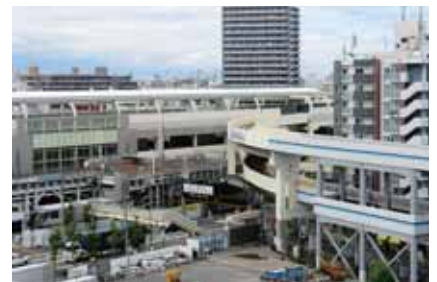
⑫京浜急行線連続立体交差事業 及び 関連街路の整備
