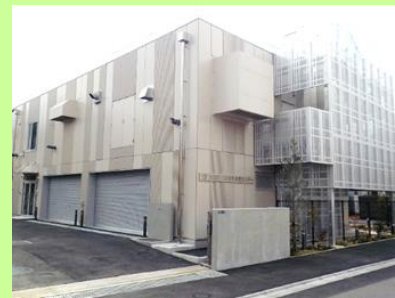
田園調布水防センター
