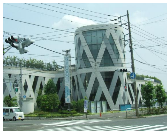
大田区総合体育館
