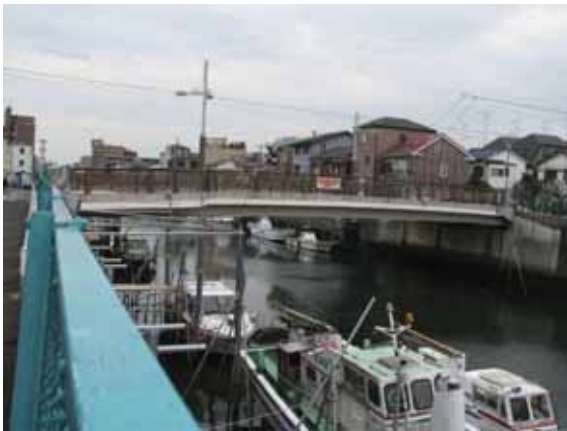
耐震補強工事（北糞谷橋）
