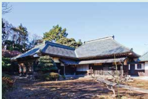
「天明家住宅」南面全景(解体前)
