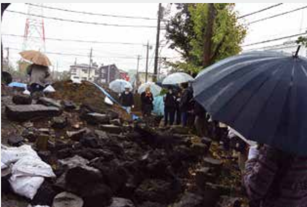
富士塚修理現場の見学
