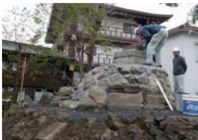
富士塚の解体工事
