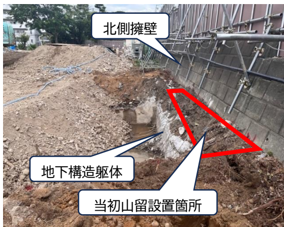
地下構造躯体と北側擁壁の状況写真①
