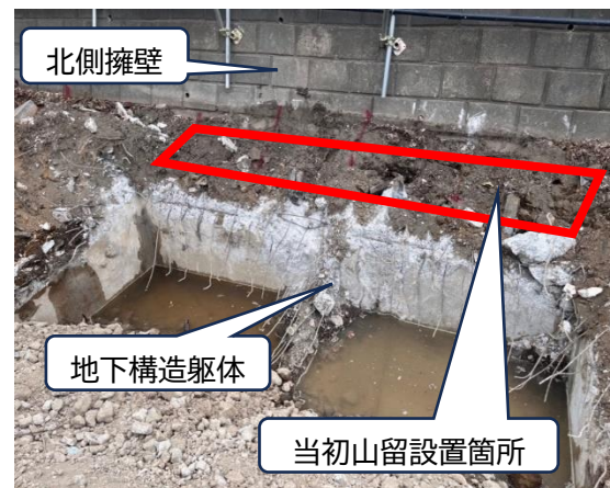
地下構造躯体と北側擁壁の状況写真②
