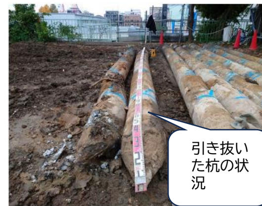
既存校舎の杭の状況写真③
