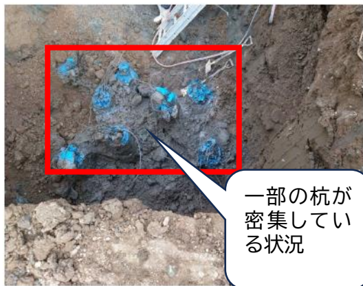
既存校舎の杭の状況写真①
