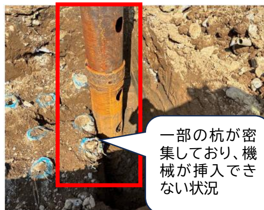
既存校舎の杭の状況写真②
