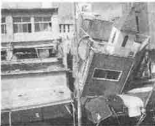
車窓から見た倒壊状況
