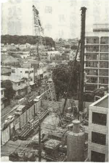
区役所から見た工事現場 (写真提供：東京都下水道局)
