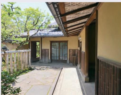
旧川端龍子邸主屋、中門前から玄関を見る
