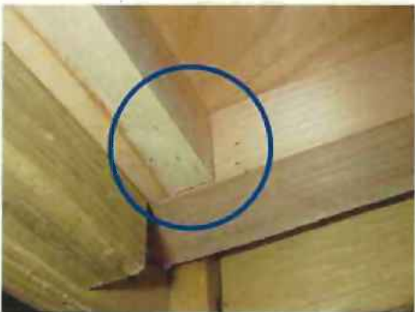
▲このような1~3個のわずかな 糞にも注意 小さな墨色の点、又はそれより 小さい黒い点 (約1~2mm) (糞の大きさも個体により異なる)
