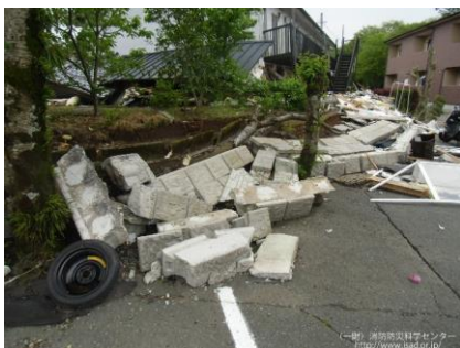
[ブロック塀の倒壊]
