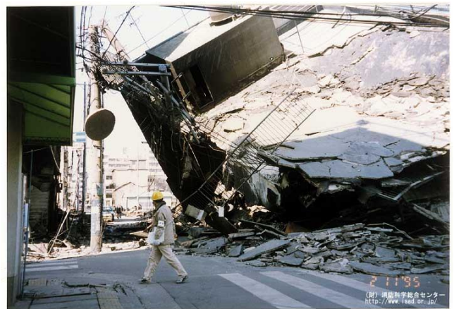
[建物倒壊による道路閉塞]
