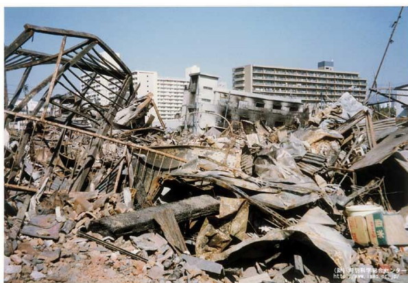
[延焼火災による被害]
