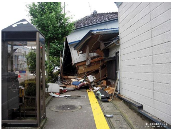
[木造住宅の倒壊による道路閉塞]
