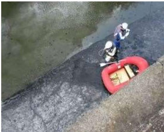
写真 2. 6 汚泥堆積状況（遠景）
