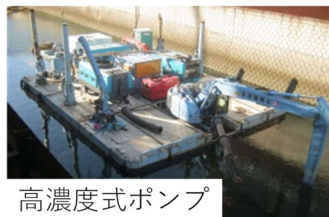
写真 3-3-1 前回の河床整正工事の状況
