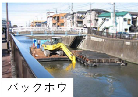
写真 3-3-1 前回の河床整正工事の状況
