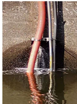
写真3-4-1 不具合箇所 (コンプレッサの異常と取水ホースからの漏水)
