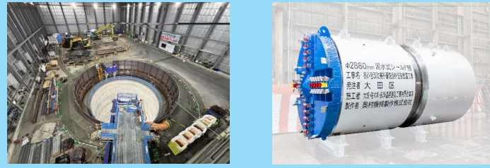
呑川幹線中流域の整備状況 (左:立坑竣工 右:シールドマシン)
