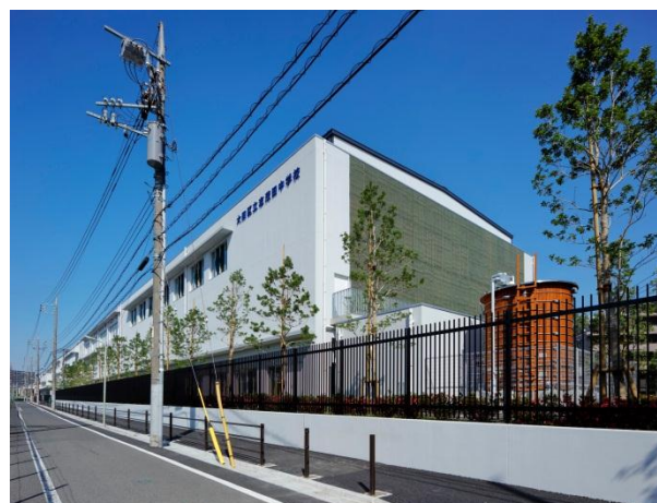
【50】壁面緑化(志茂田中学校)
