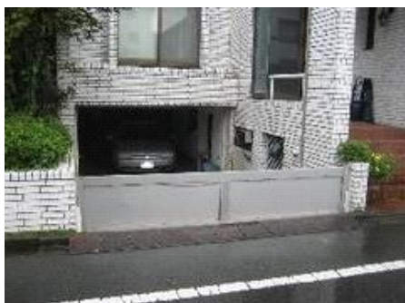
②「止水板」を設置 地下・半地下施設には、「止水板」を設置する。
