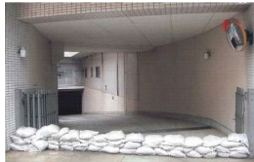
③「土のう」による浸水対策 地下の出入口に「土のう」を積む。
