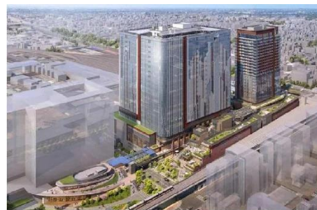
写真：大井町トラックス（工事中）
