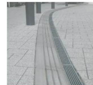
細目スリット側溝
