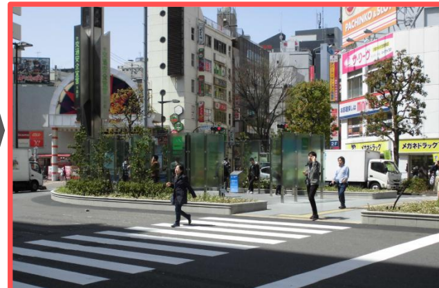
改修完了後（交通島全景）
