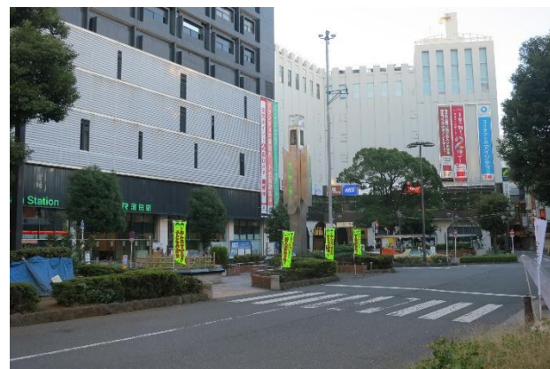
改修前（交通島全景）
