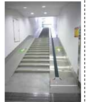
オートスロープ付き階段 (Luz 大森地下自転車等駐車場)
