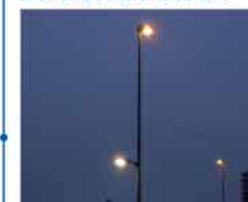
横断歩道付近を照らす歩行者兼自動車用街路灯
