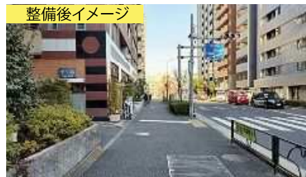
<品川区東大井5丁目付近>整備済区間
