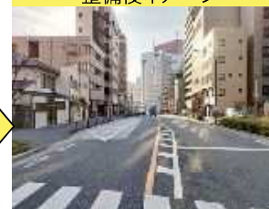
<品川区東大井5丁目付近>整備済区間
