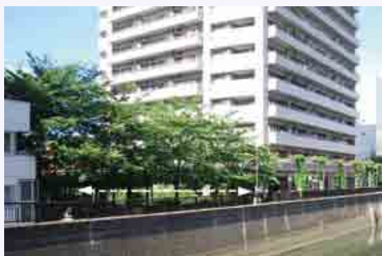
○川側に開かれた公開空地と川の反対側の道路を結ぶ通り抜け通路を設けています。(蒲田 A1, A3)
