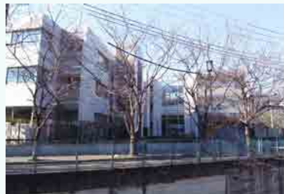
○雁行した建て方で川の屈曲部に対応するとともに、ケヤキ並木のスカイラインにも調和しています。(石川町 C3)
