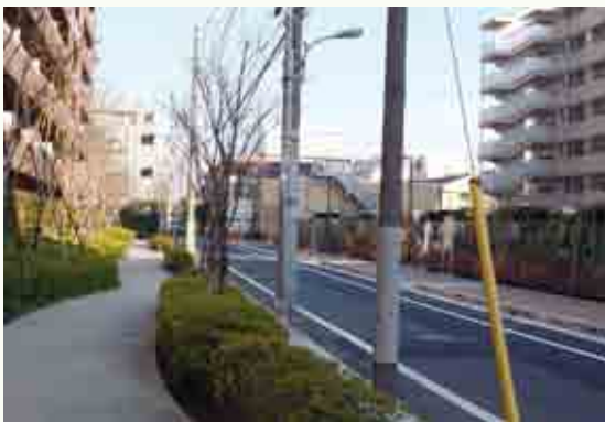
○道路の南北にそれぞれに建つ集合住宅は表情が変わってきますが、一体的な景観づくりへの工夫が望まれます。ここでは、北側では緑道のような歩道状空地を設け、南側は駐輪施設ながら整った外構としています。(大森西 D2, D5)
