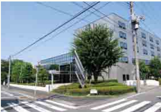
○開放的な外構にして、まちかどにシンボル樹を置いています。(東糀谷 D1, D2)
