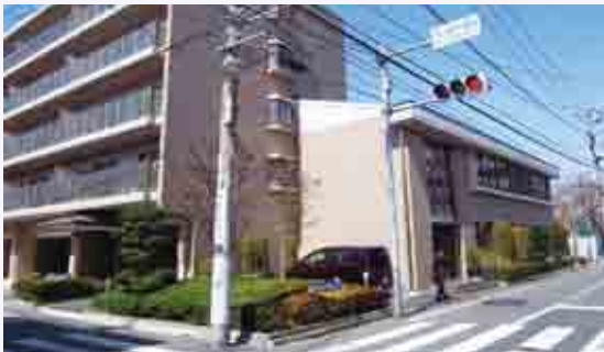
○工場と集合住宅を複合した建築物で、道路沿いに棟を配置し、建築物の裏側とピロティを利用し駐車場を設け、まちかどを緑化する等、街並みを意識しています。(西六郷 A1, A2, A4)
