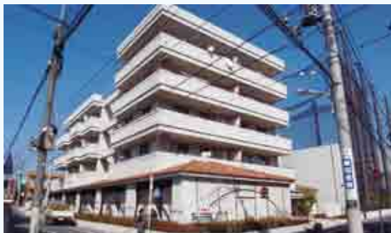
○分節した建て方によって周囲の街並みになじませていきます。（東糀谷 B1）
