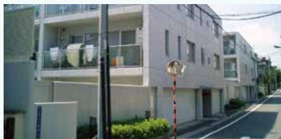
○建築物を分棟し、駐車場やゴミ置き場を組み込んでいます。(山王 C1, C4)
