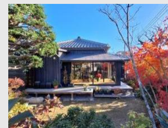
【第4回】築145年の南馬込古民家改修
