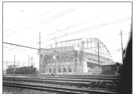
図1-3-32 環状8号線(建設中の蒲田陸橋)
