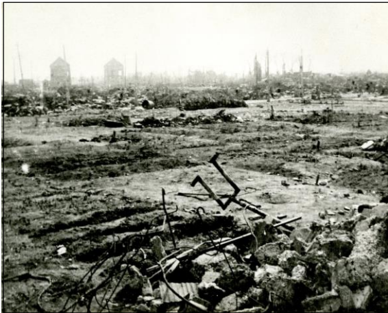
図1-3-27 被災状況(大森5丁目、現：大森西6丁目付近)(昭和20年(1945))
