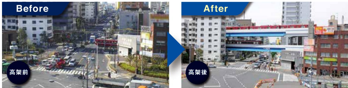
図 1-3-33 京浜急行本線の連続立体高架化の高架前後(環状 8 号線との交差部)
