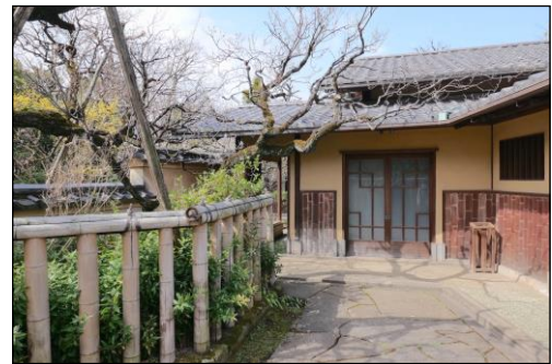
図 2-7-3 旧川端龍子邸(主屋)の外観
