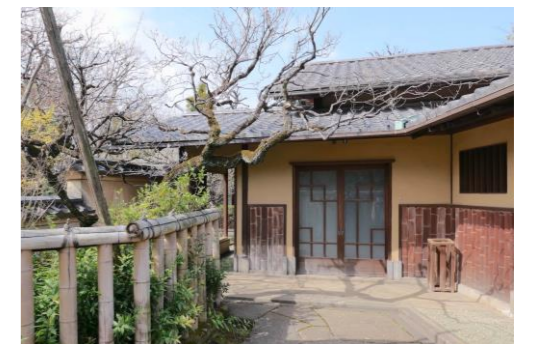
図 旧川端龍子邸(主屋)の外観
